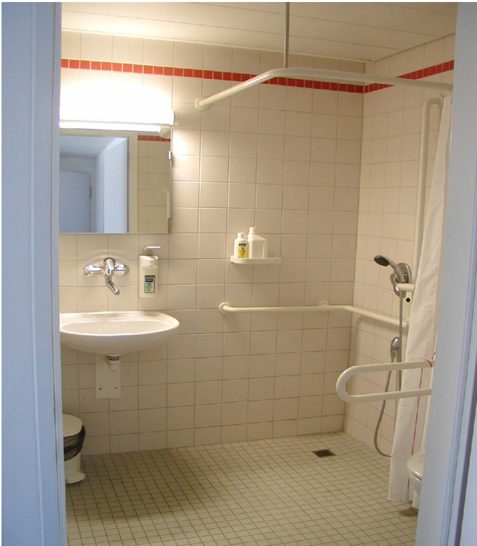
Blick in eine Nasszelle ausgestattet mit Waschbecken, Dusche (auch für Rollstuhlfahrer ebenerdig), Toilettenbecken mit Haltegriff
